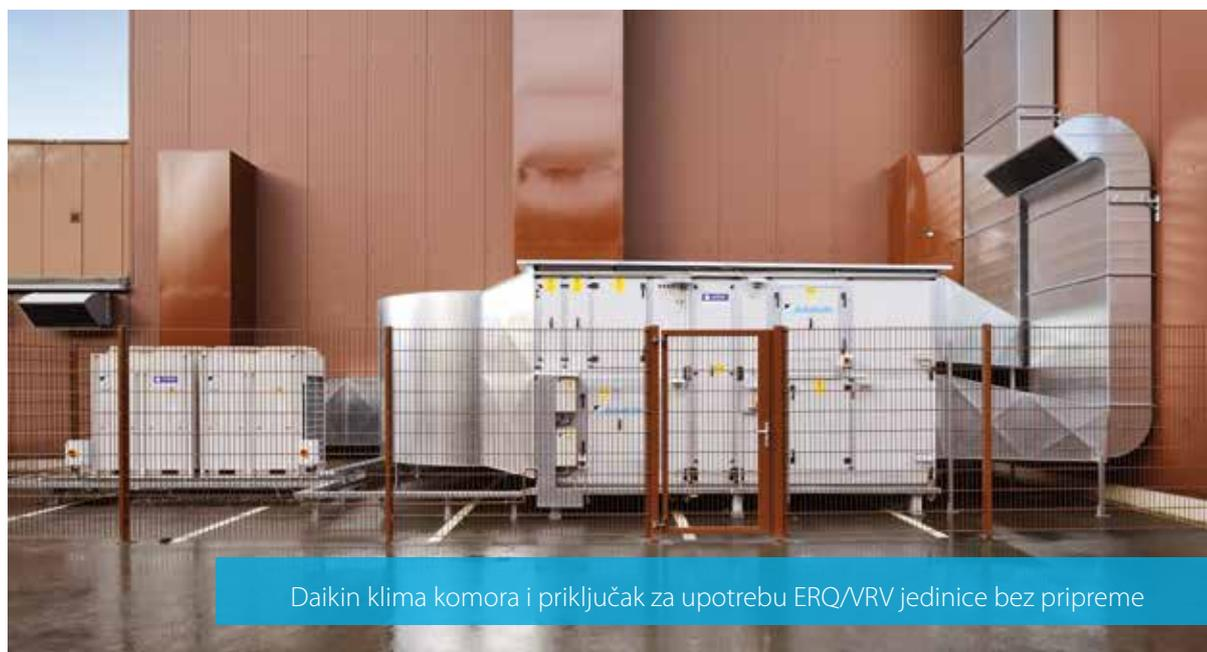
Daikin klima komora i priključak za upotrebu ERQ/VRV jedinice bez pripreme
