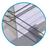
3-cijevni cjevovod radne tvari
